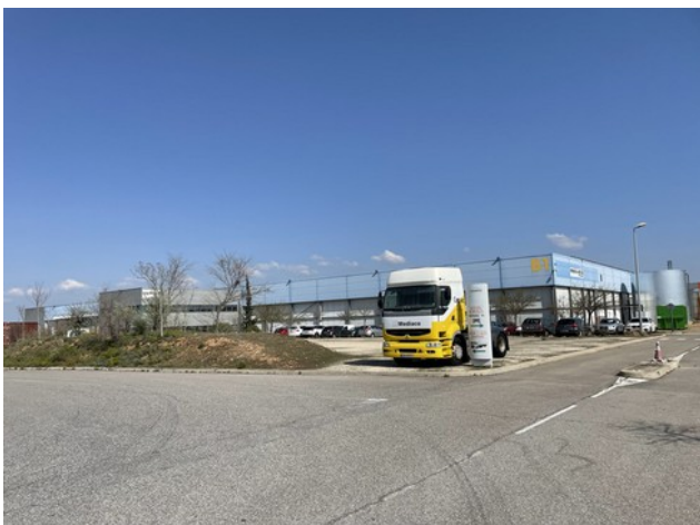
Entrée du site de MEDIACO
